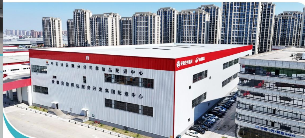
中石油非油品三期仓库
