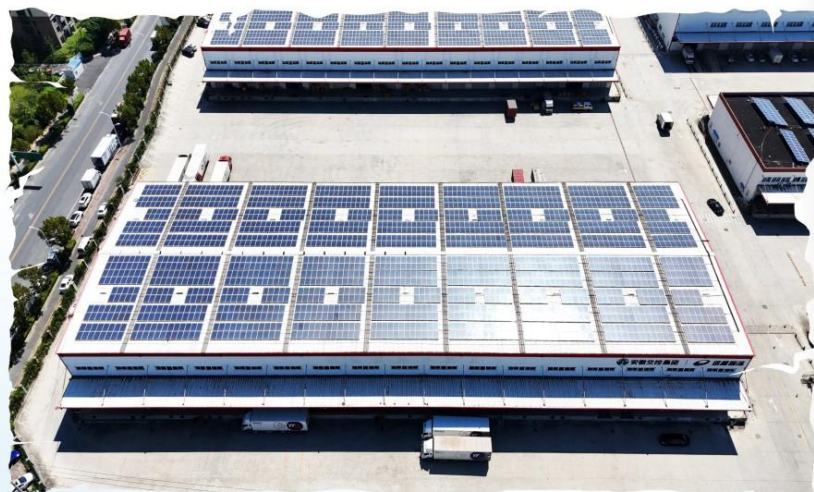
园区屋顶光伏发电
